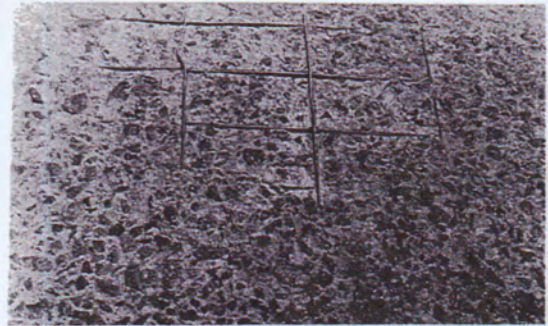
Fig. A.2.1-Abrasion damage
