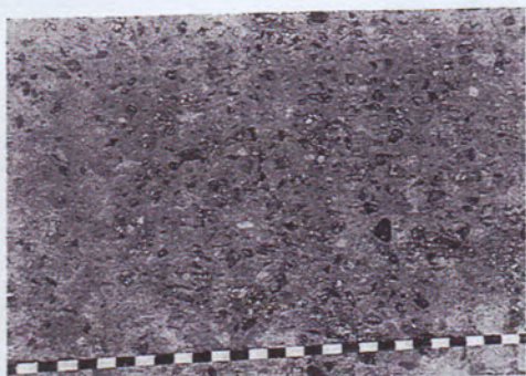
Fig. A.2.20.2b-Close-up scaling (medium)
