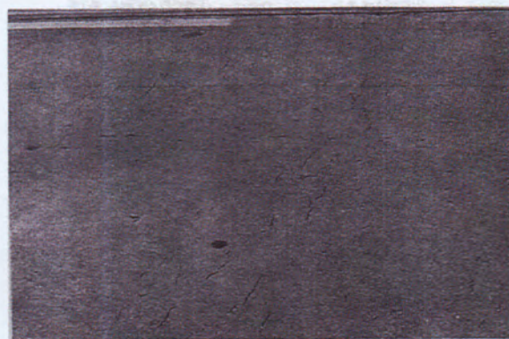
Fig. A.1.7-Plastic cracking
