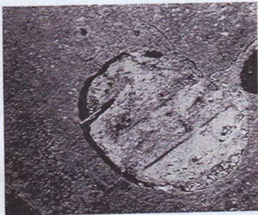
Fig. A.2.21.2—Large spall
