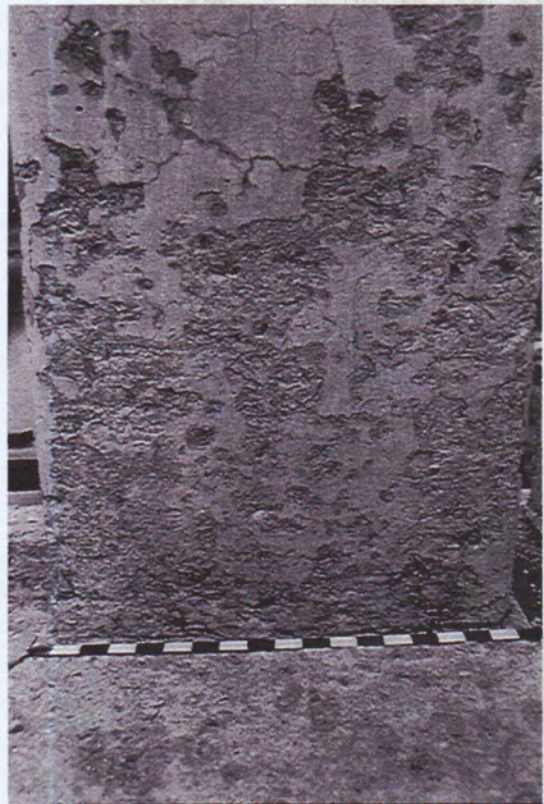
Fig. A.2.20.2a-Scaling (medium)
