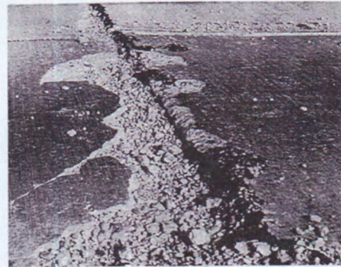
Fig. A.2.16a-Joint spall
